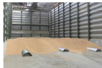
Belüftungsspiralschlauch
