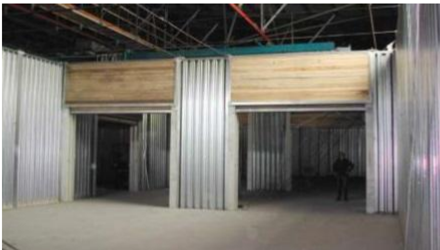
Modulwand Boxen mit Bohlenschott
