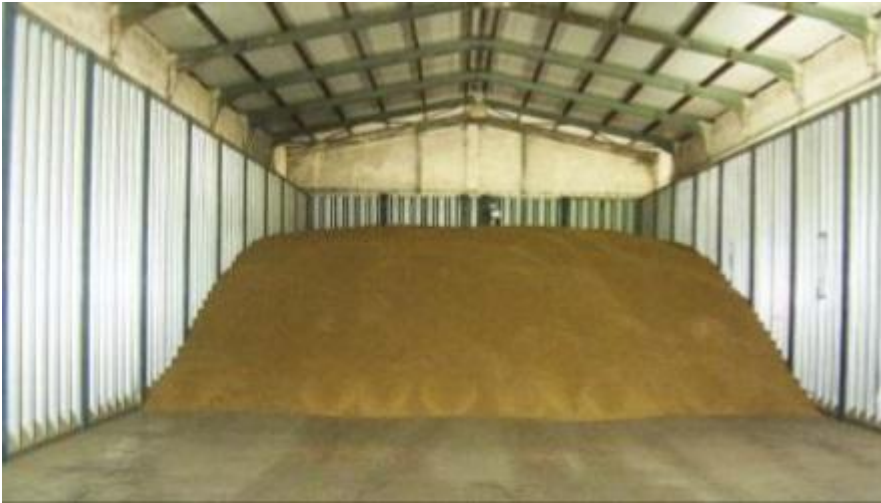
Modulwand um bestehende Halle beschüttbar zu machen
