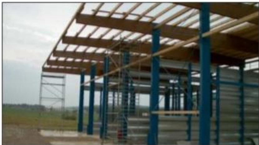
Halle mit Dammwand bei der Montage
