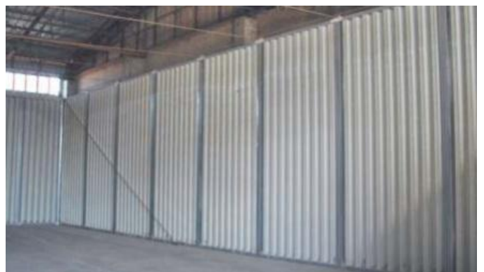
Modulwand abgespannt
