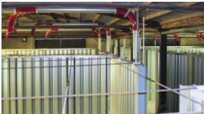
Modulwand Boxen abgespannt
