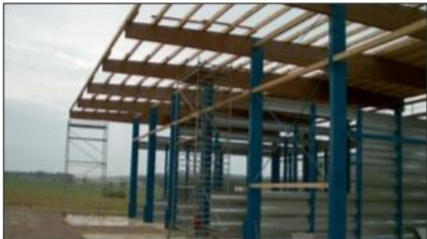
Halle mit Dammwand bei der Montage
